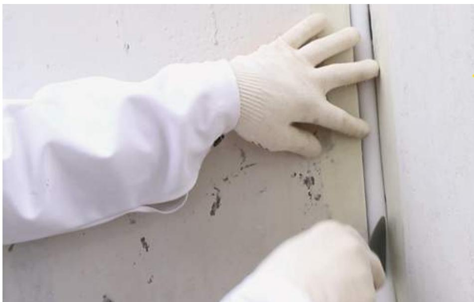
Жгут, устанавливаемый в стыке, должен быть обжат на 20-50% от своего первоначального диаметра.
