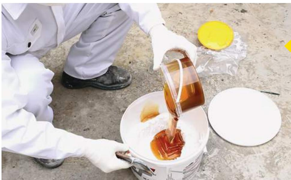
После вливания отвердителя в основную пасту, снимите шпателем остатки отвердителя со стенок упаковки и перенесите их в тару с основной пастой.
